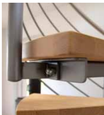
Stufenaufleger und Geländerbefestigung – jederzeit demontierbar.
