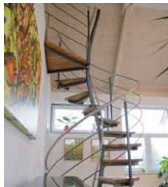
Ohne Wandbefestigungen die nächste Etage erklimmen.
