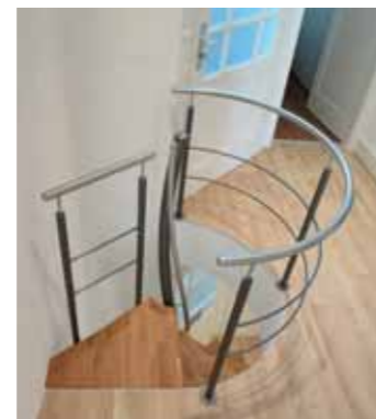
Gebogenes Brüstungsgeländer für rundes Deckenloch.
