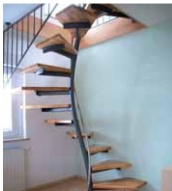
„Die Ecklösung“ – Stufen laufen in die Ecken für eine optimale Raumausnutzung.
