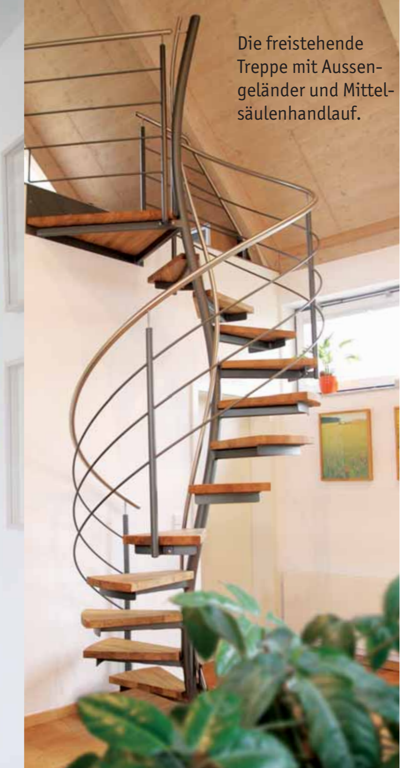
360°-Aussengeländer mit 3 Relingstäben und Edelstahl- handlauf.
