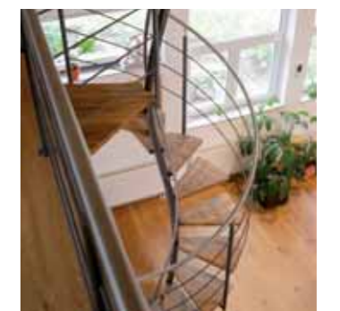
360°-Aussengeländer mit 3 Relingstäben und Edelstahl- handlauf.
