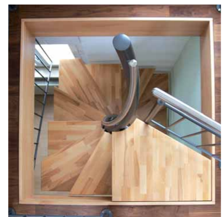
Treppe als Ecklösung mit Mittelsäulenhand- lauf in Edelstahl.
